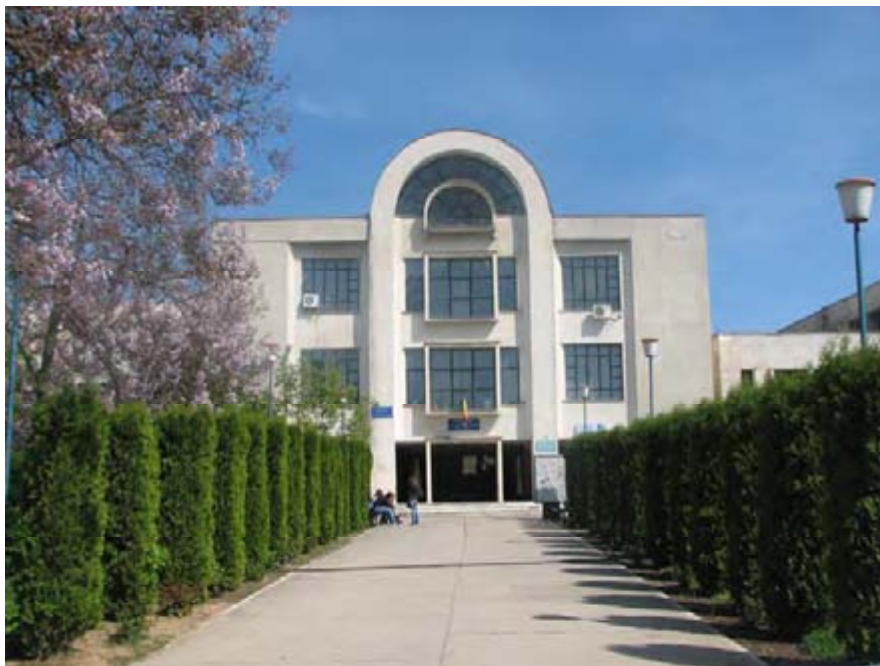
Clădirea Facultății de Automatică (2007)
